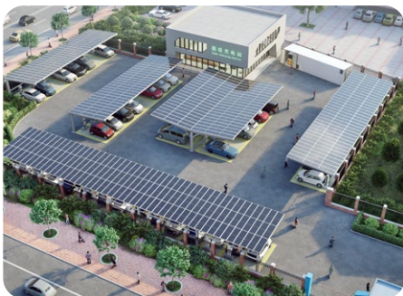
PV・ストレージ・チャージングカーポート
